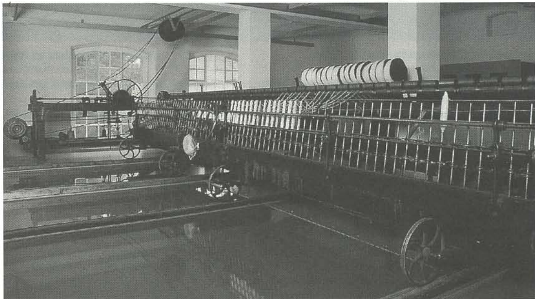
Rheinisches Industriemuseum, Außenstelle Ratingen, Spinning Mule zum Feinspinnen von Garn, um 1845
